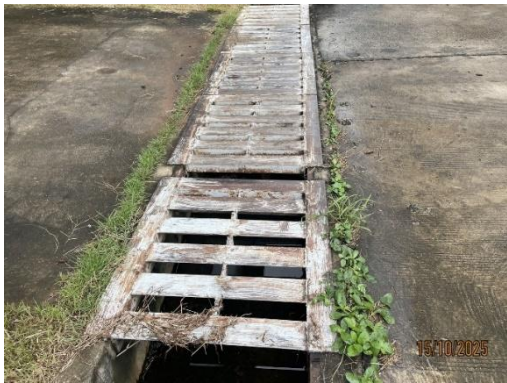
รูปที่ 32 รางระบายน้ำฝนภายในพื้นที่โครงการ
