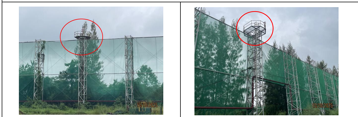
ท่อน้ำดับเพลิงรอบลานกองกากอ้อย
